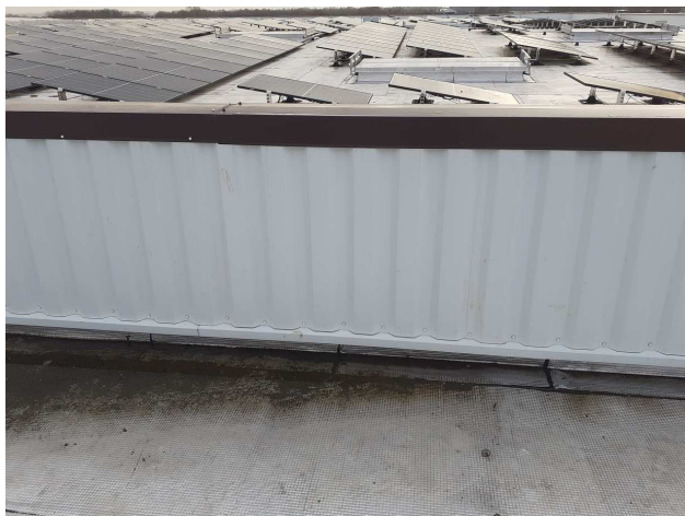
Photo 6 : mur CF dépassant de 1 m (mesuré à 1,10 m)
