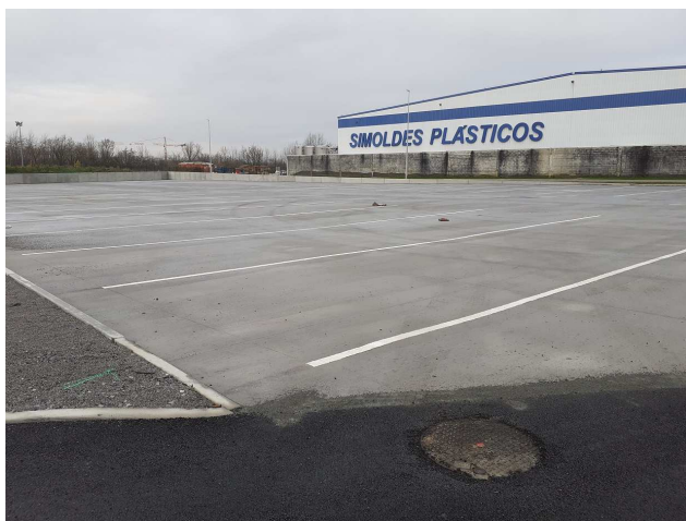
Photo 17 : zone de stockage extérieure (1/3 du volume est destiné au confinement des eaux d'extinction incendie)
