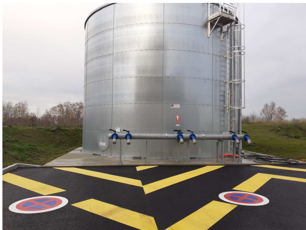
Photo 13 : réserve incendie de 483 m 3 – aires d'aspiration et voie de stationnement
