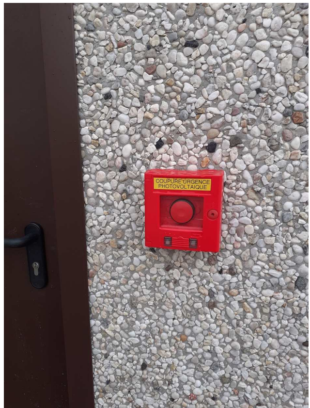
Photo 12 : arrêt d'urgence en façade -panneaux photovoltaïques
