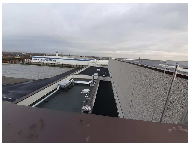
Photo 8 : vue vers bureaux 3 et local de charge-dépassement du mur CF en toiture
